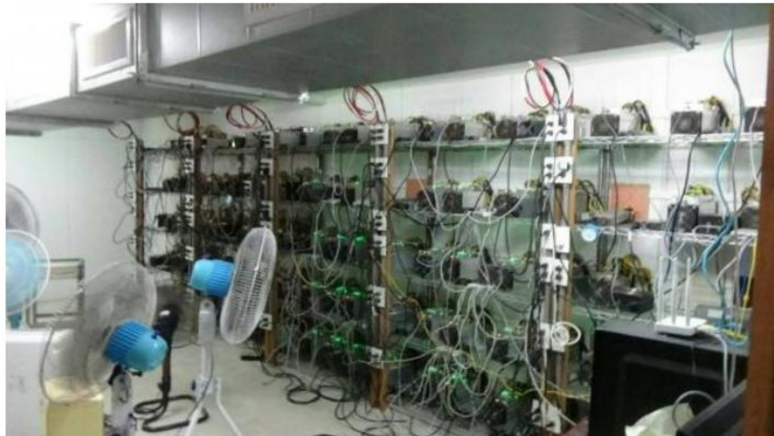
台電在嘉縣東石鄉黃石吟自家鐵皮屋查獲比特幣挖礦機房。(記者丁偉杰翻攝)
